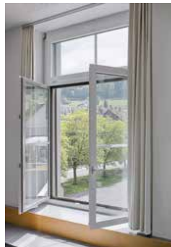
Der Einbau von RF1 Wechselrahmenfenstern im Schulgebäude Oberrieden stellte besonders hohe Anforderungen an Sicherheit und Robustheit. Eingebaut wurden 282 Flügel, 97 Rahmen sowie 12 Bogenfenster.
